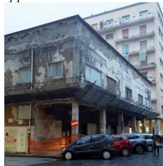
L'ex Cinema Capitol in via A. Sorrentino.
